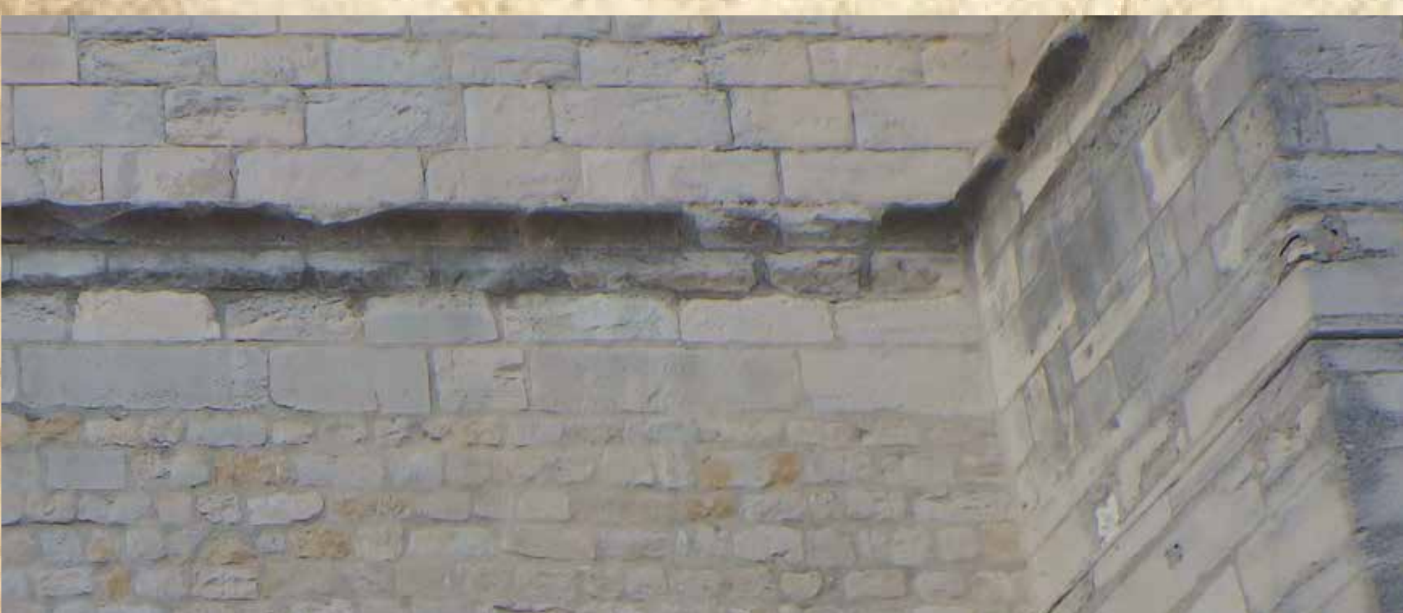
← Détail de la saignée peut-être liée à la construction d'une sacristie au XIV e s. (cl. : A. Brunin).
