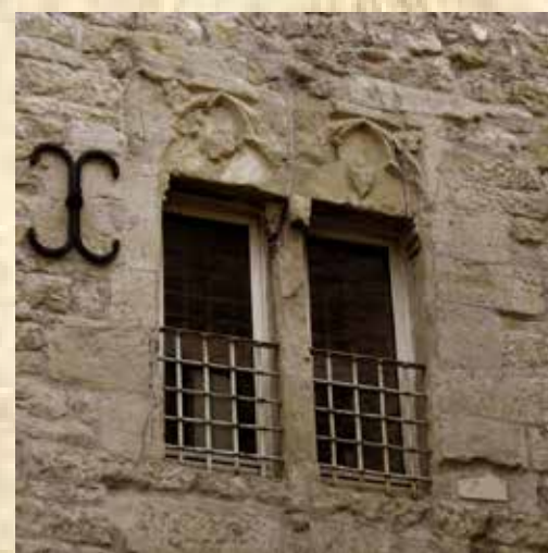
Fenêtres géminées appartenant probablement au collège pontifical
